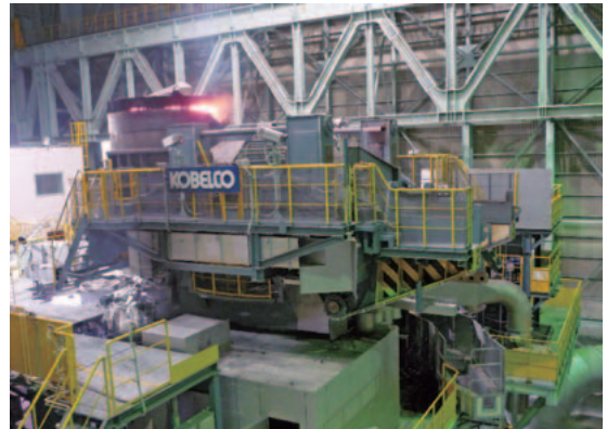
図11 鋳造中のスウィングタワー
