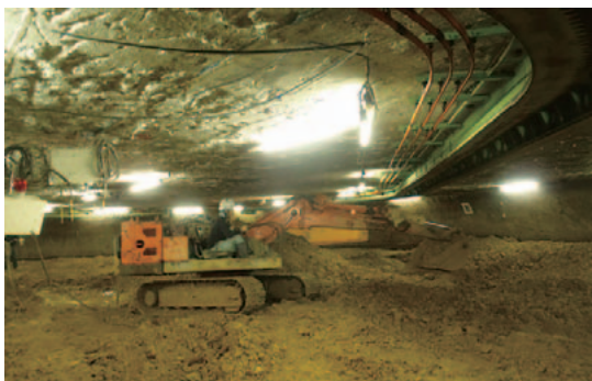
図8 地下作業室内での掘削状況
