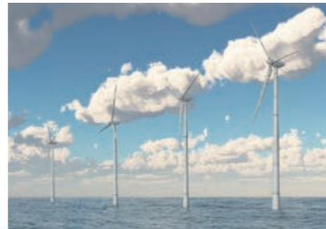
図1 風力発電設備外観
