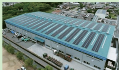
製品倉庫屋上の太陽光発電設備
