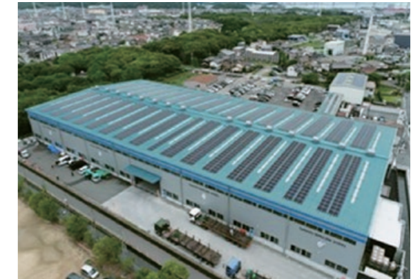
製品倉庫屋上の太陽光発電設備
