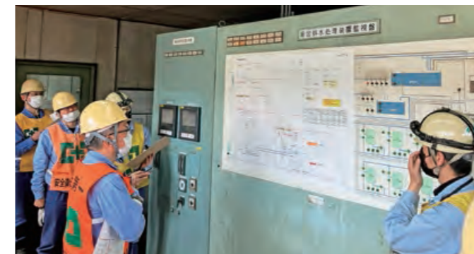
排水処理施設のパトロール
