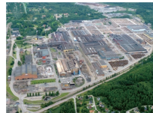
水素プラントが建設されるOvakoのHofors工場
