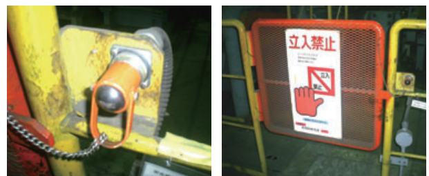
安全装置(左)・安全柵(右)の設置
