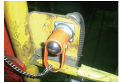
安全設備の設置
