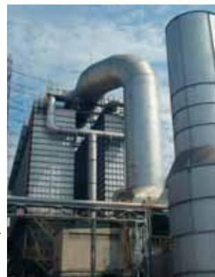
電気炉集塵設備
