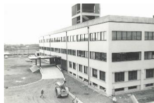
新社屋 (現 本社事務所) 建設 (1964年)
